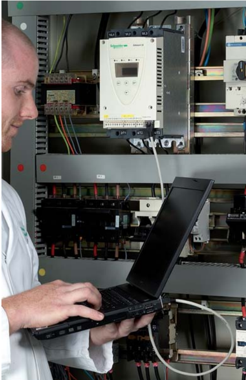
Конфигурирование ATS 22 при помощи программного обеспечения SoMove Lite
